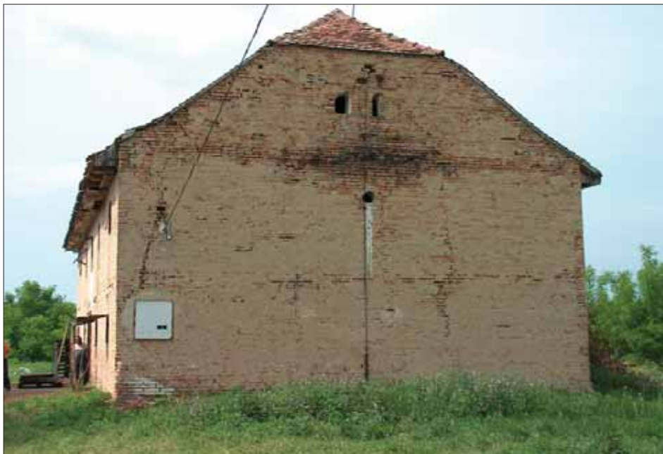
Slika 3.: Mjesto boravišta kukuvije može se otkriti i po tragovima izmeta koje ostavlja na otvorima zgrada (Foto: Jenő J. Purger)
